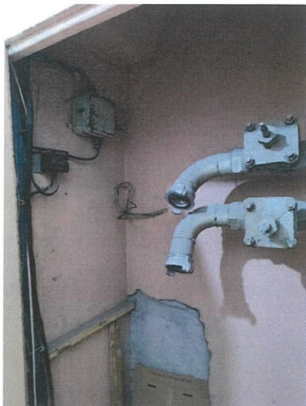
Фото 43. Неукомплектованный шкаф. Вентили без маховиков
