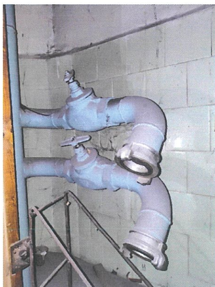
Фото 7. Неукомплектованный шкаф
