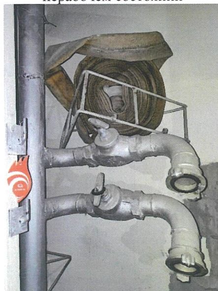
Фото 58. Рукав в нерабочем состоянии
