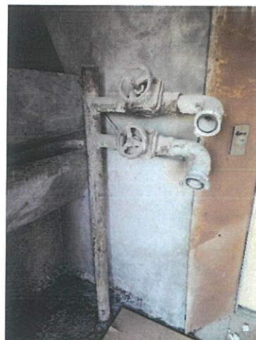
Фото 56. Пожарный кран без рукава и стволов
