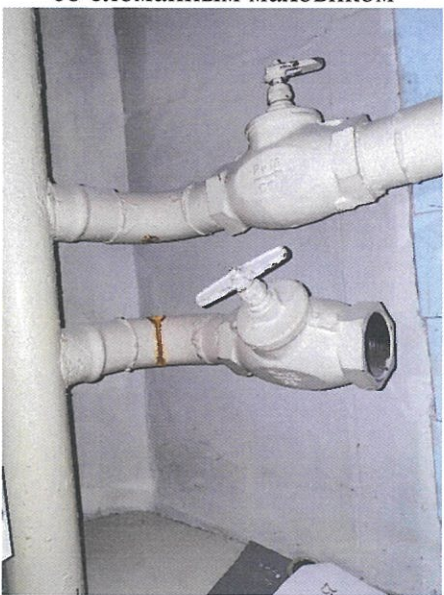
Фото 53. Следы течи в трубе. Отсутствуют цапковые соединения
