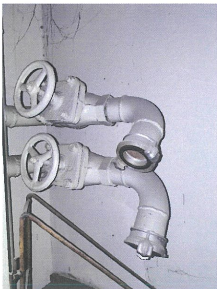
Фото 19. Неукомплектованный шкаф
