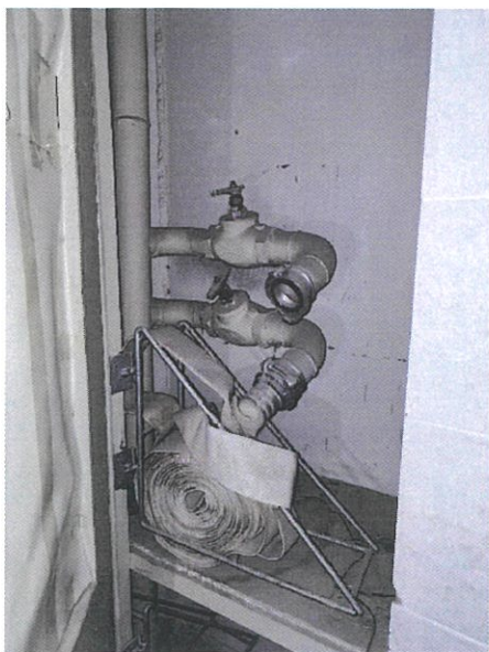
Фото 51. Укомплектованный шкаф. Вентиль со сломанным маховиком
