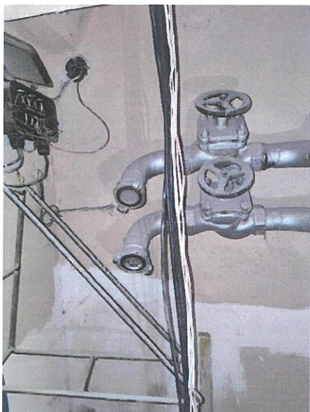
Фото 31. На месте расположения кранов проложены электрические кабели
