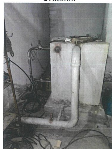
Фото 58. Водонапорный бак технического этажа
