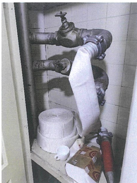
Фото 25. Вентили со сломанным и отсутствующим маховиками
