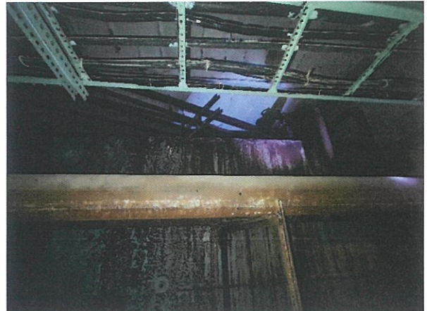
Фото 2. Сплошная коррозия трубы
