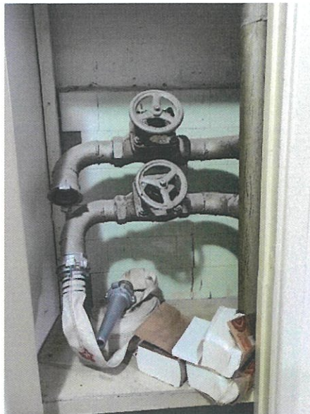
Фото 22. Неукомплектованный шкаф
