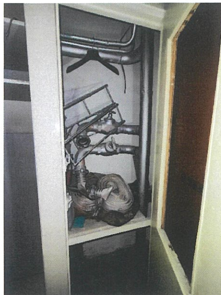
Фото 56. Пожарный шкаф. Рукав в нерабочем состоянии
