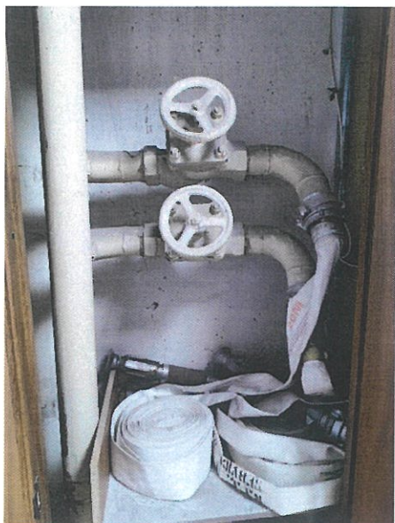
Фото 35. Укомплектованный шкаф
