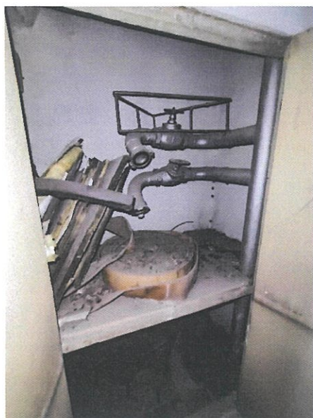
Фото 57. Рукав в нерабочем состоянии
