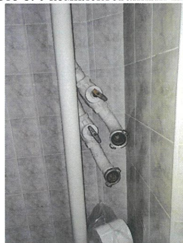
Фото 10. Отсутствует укомплектованный шкаф
