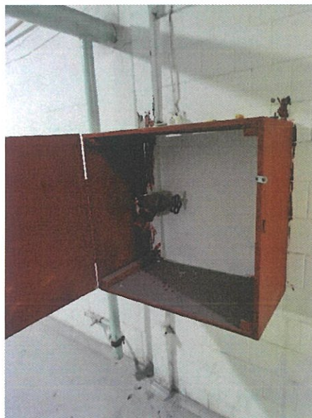
Фото 6. Неукомплектованный пожарный шкаф
