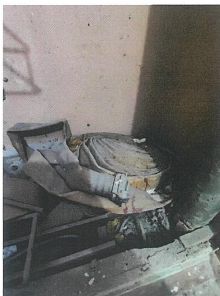
Фото 50. Рукав в нерабочем состоянии
