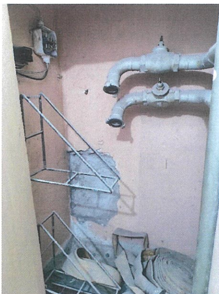
Фото 47. Неукомплектованный шкаф. Вентили без маховиков
