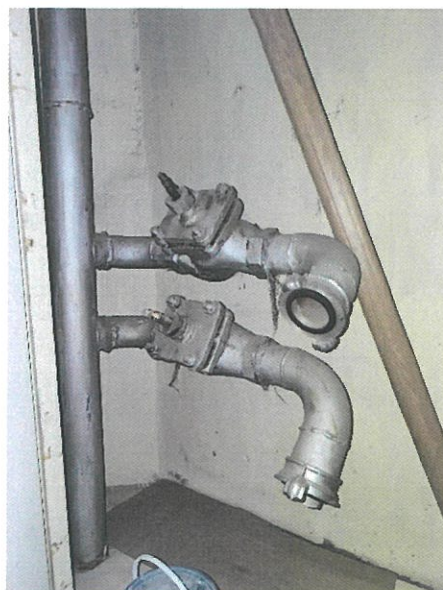
Фото 32. (Отсутствуют маховики на вентильях
