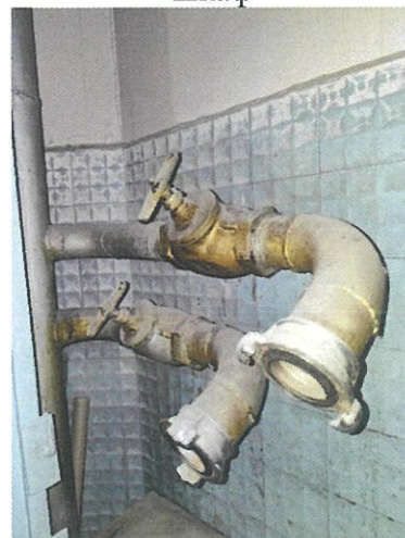
Фото 12. Отсутствует укомплектованный шкаф
