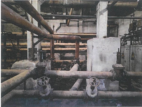
Фото 1. Узел подключения в подвальном помещении
