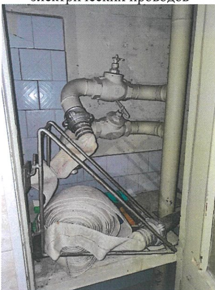
Фото 54. Вентиль со сломанным маховиком
